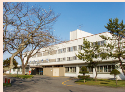
町立病院の改築
